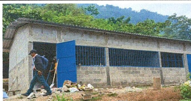
Foto: 4 INSTALACIÓN DE ESTRUCTURA MÓDULO 2
