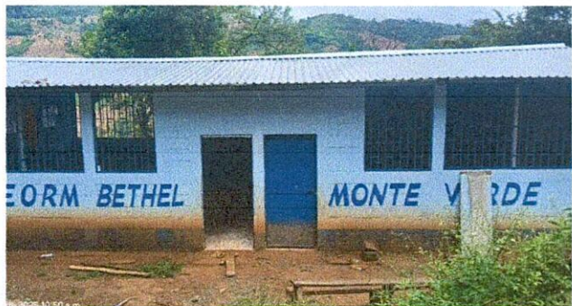
Foto: 1 INSTALACIÓN DE BARANDALES EN MÓDULO 1
