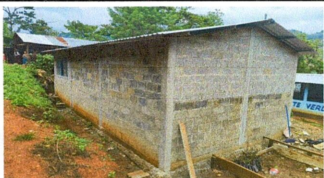
Foto: 3 MEJORAMIENTO DE PARED MÓDULO 2
